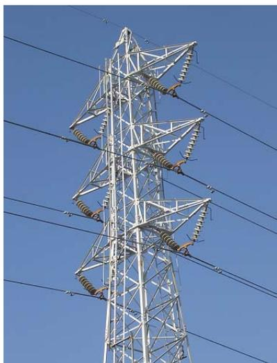
写真 2 単導体の高圧送電線
