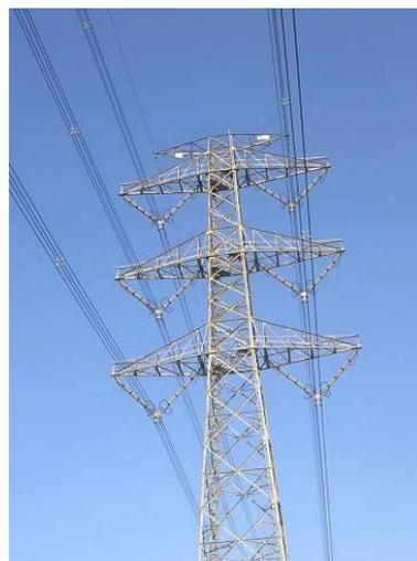
写真4 4導体の超高压送電線
