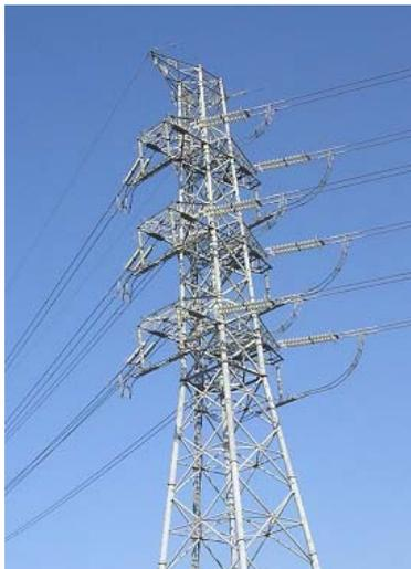
写真3 複導体の超高压送電線
