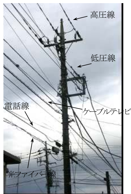
写真1 配電線柱全景
