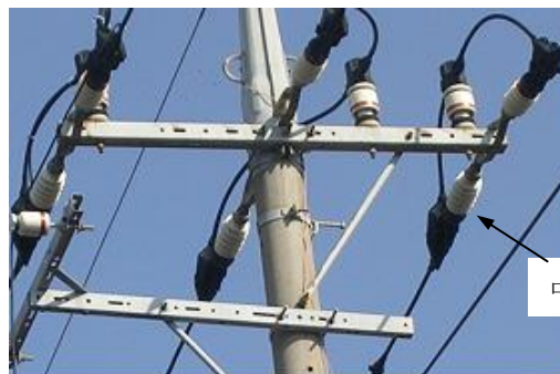
写真6 中実がいしによる対策
