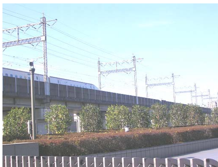
写真1 新幹線高架線路
